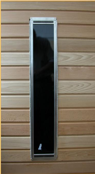
Zwangsläufig führt das natürlich dazu, dass, nach dem Einbau des Strahlers, ringsum dieses Band unschön zu sehen ist.
