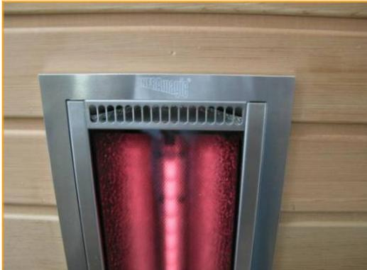
...und **Ablufts**chlitzte oben an der Vorderseite des Strahlers, durch die die heiße Luft entweicht.
