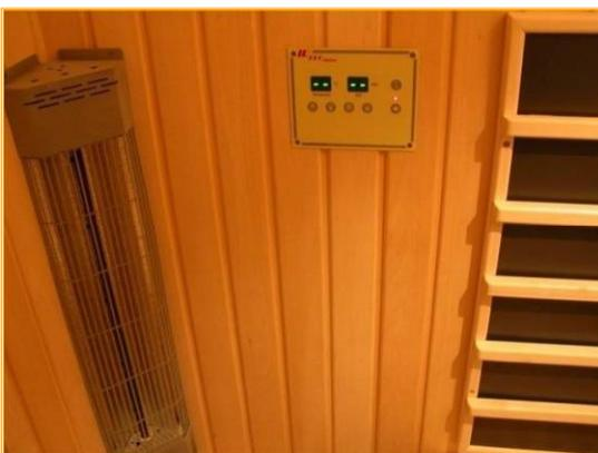
Im vorderen Bereich einer Infrarot Wärmekabine müssen jedoch immer Reflektorstrahler verwendet werden, da die von den Flächenstrahlern ausgesandte langwellige Infrarotstrahlung nicht in der Lage ist größere Distanzen zu überwinden.
