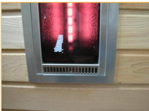
Erreicht wird dieser Effekt durch **Zuluft**schlitze unten an der Vorderseite des Strahlers, in die die kühlere Luft eintritt...
