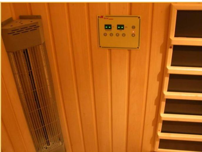
Um einen optimalen Schwitzprozess in Ihrer Kabine zu erzielen ist anzumerken, dass eine optimale Ausstattung die **Kombination von Flächenheizungen im rückwärtigen** und herkömmlichen **Infrarotstrahlern im vorderen Bereich** darstellt.
